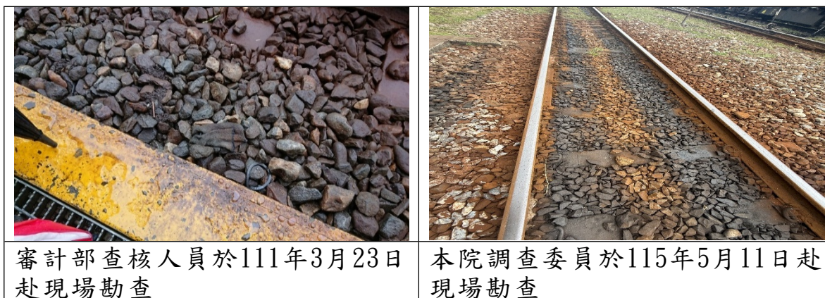
圖1 審計部查核人員、本院調查委員於花蓮機務段實地拍攝，發現加油作業場所鐵軌上道碴有明顯油污
