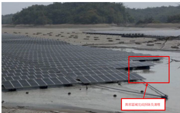
圖8 異常區域完成拆除及清運 資料來源：經濟部能源署
