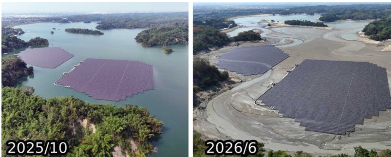
圖5 媒體報載，左圖為114年10月蓄水量充裕時的光電板，右圖旱象乾到見底，原本設置於水面的浮動式太陽能光電設施及浮筒都接觸到底泥。
