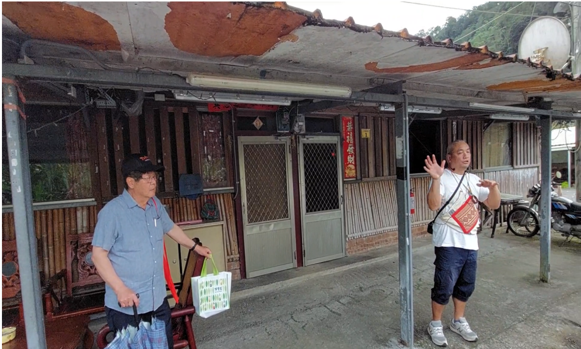
照片2 日月潭伊達邵臨時安置社區老舊、電力短缺
