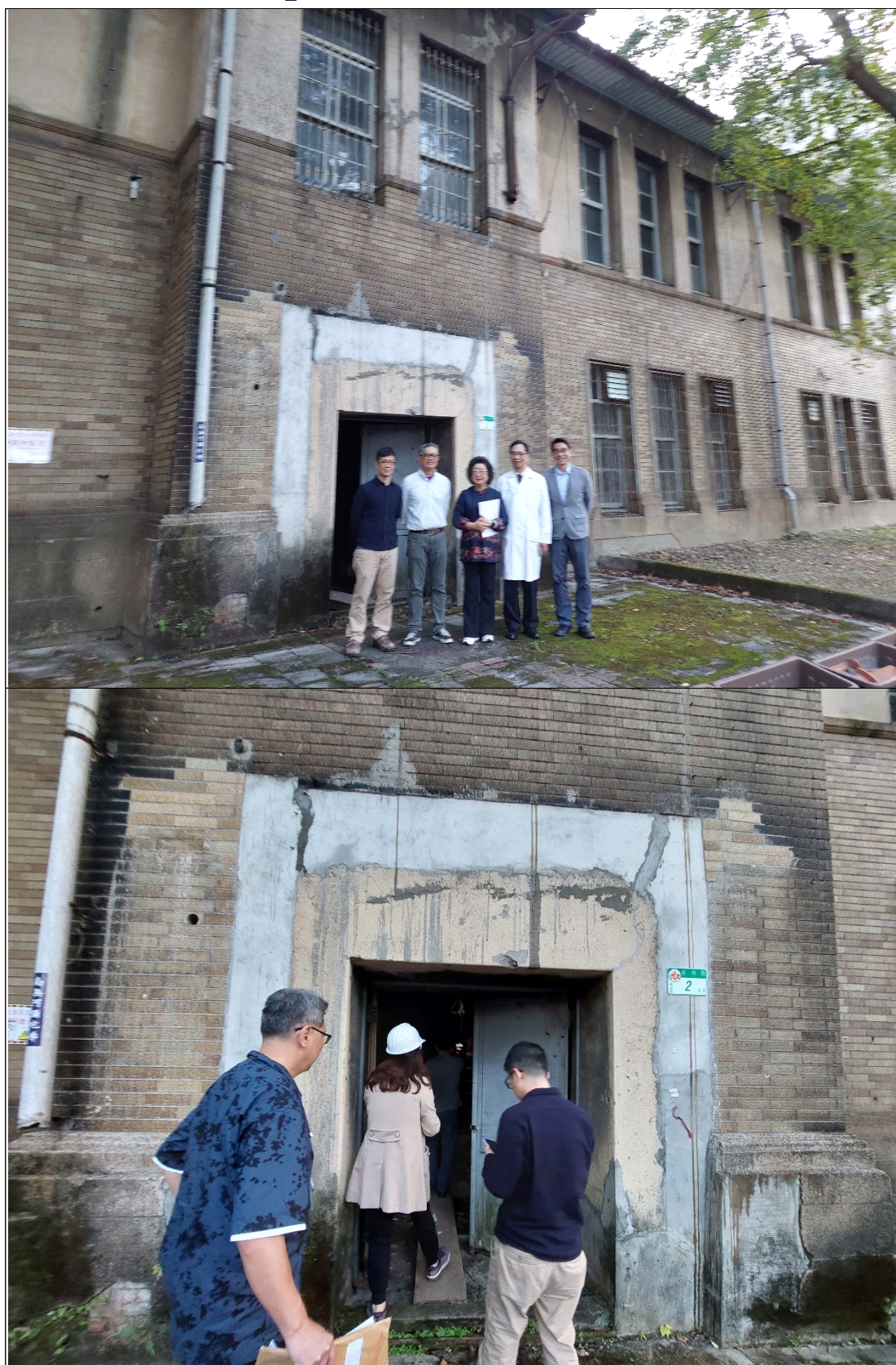
附圖三、本院112年11月27日履勘歷史建築「臺灣大學醫學院 舊藥學館」實況
