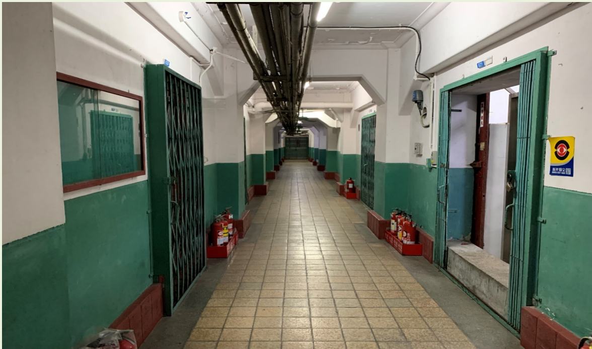
圖5 防空避難設施維護狀況良好(基隆海港大樓地下室)
