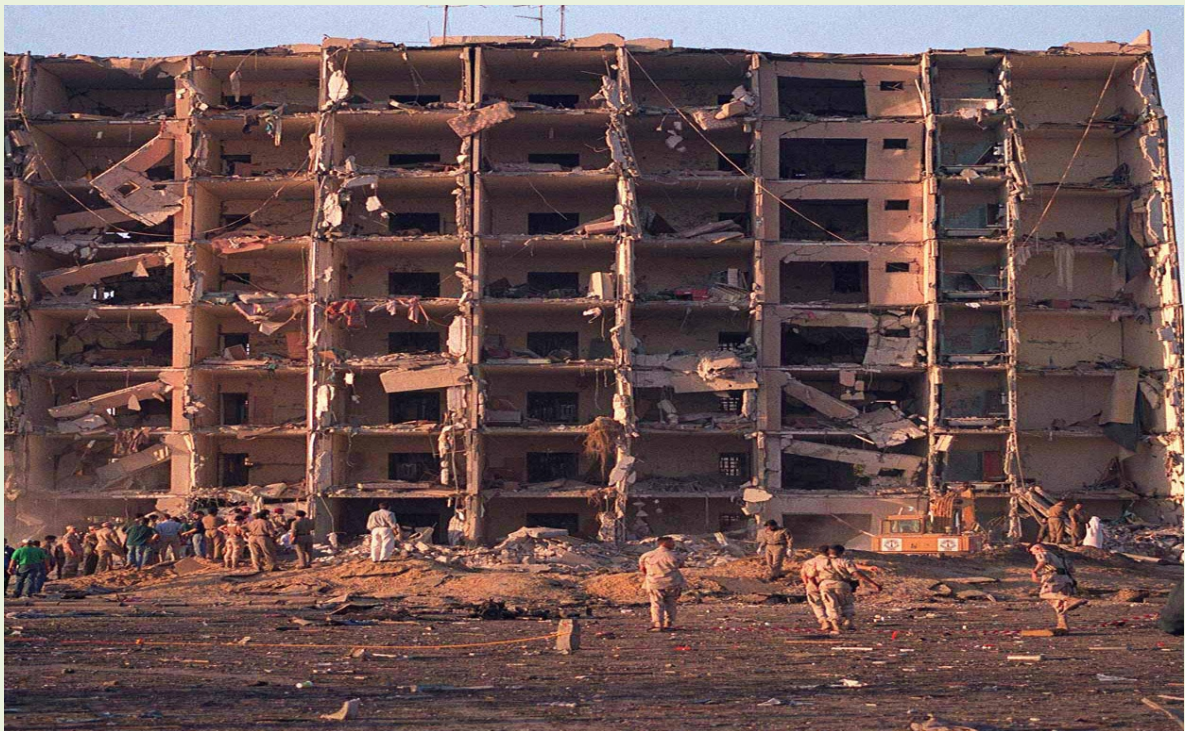
圖3 空襲後，大樓室內第2道牆後的狀況
