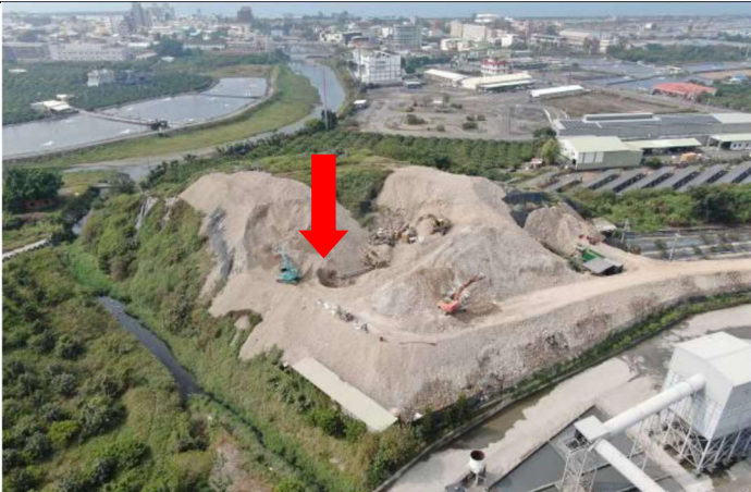
114年2月19日再利用設備隱藏在後方堆置區中央
