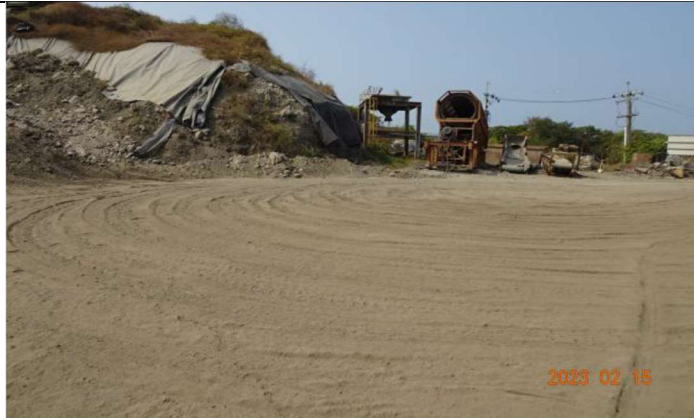
112年2月15日再利用設備未完成組裝
