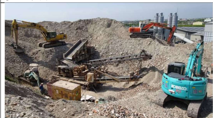
114年3月28日先經震動篩，再使用破碎機(違反作業程序)
