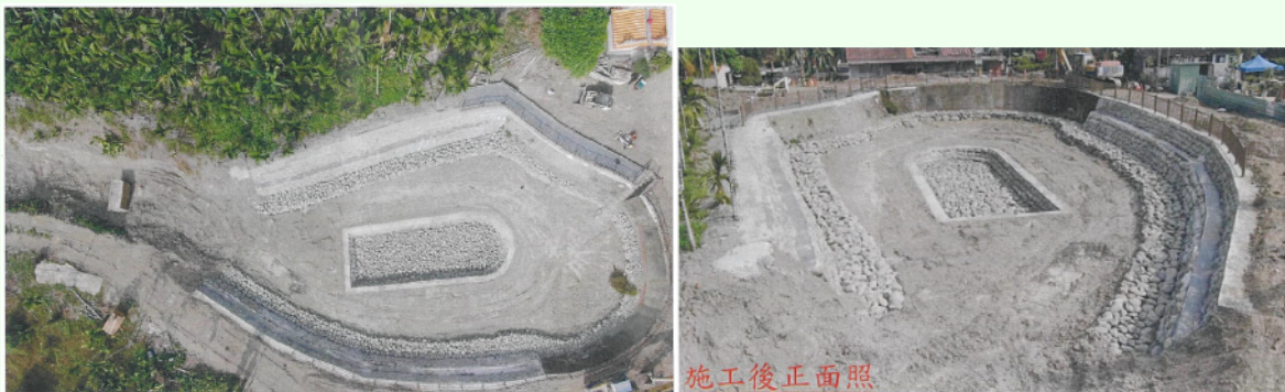
圖2 萬巒鄉成德村神農宮旁周邊環境改善工程施工後照片
