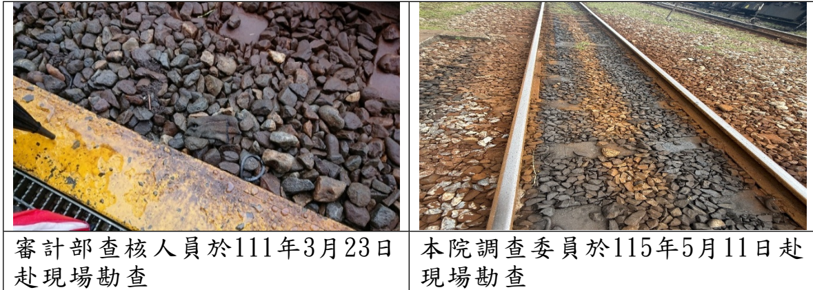
圖1 審計部查核人員、本院調查委員於花蓮機務段實地拍攝，發現加油作業場所鐵軌上道碴有明顯油污
