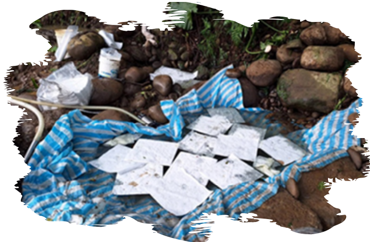
02石門大圳邊坡吸油棉佈置
