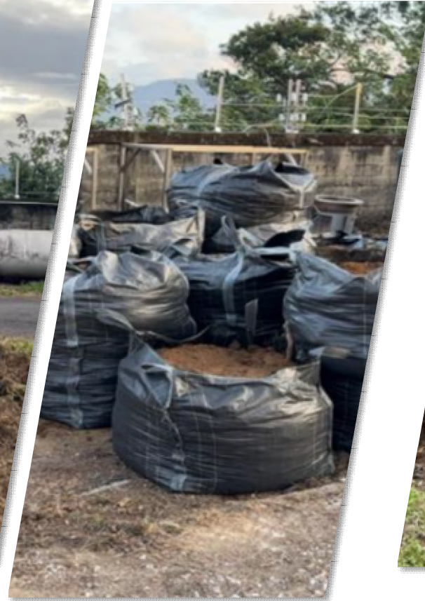
03廠區表層污染土壤移除 及受污染土壤收集暫貯
