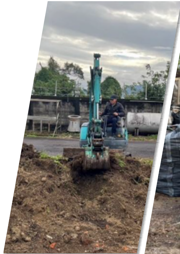
03廠區表層污染土壤移除 及受污染土壤收集暫貯
