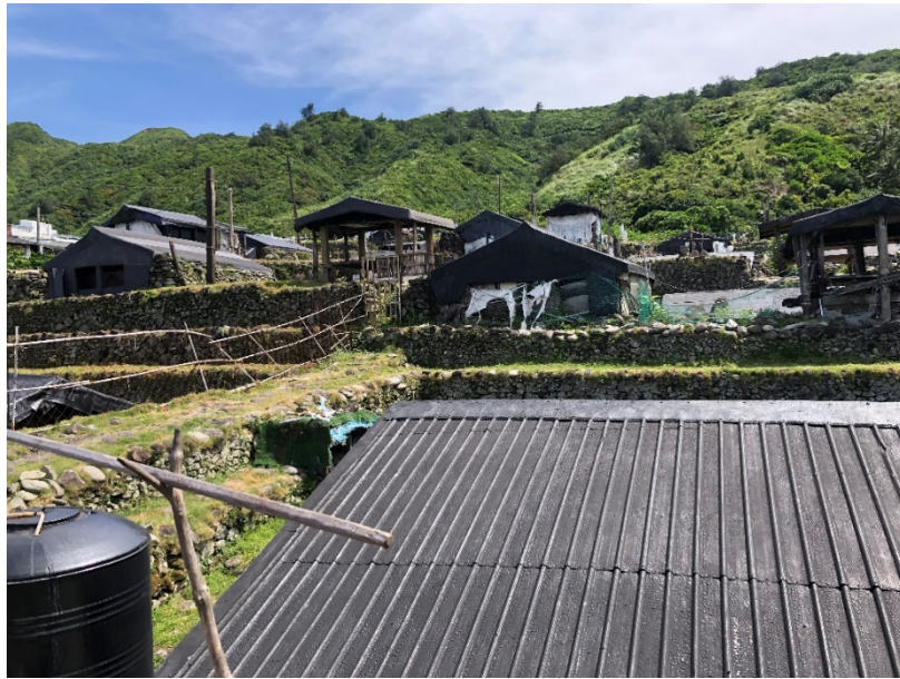
圖8 蘭嶼野銀部落地下屋現況
