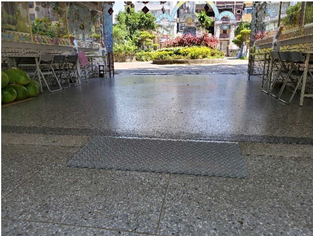
圖9 鶯歌國中活動式鋼製斜坡板 (1/2)
