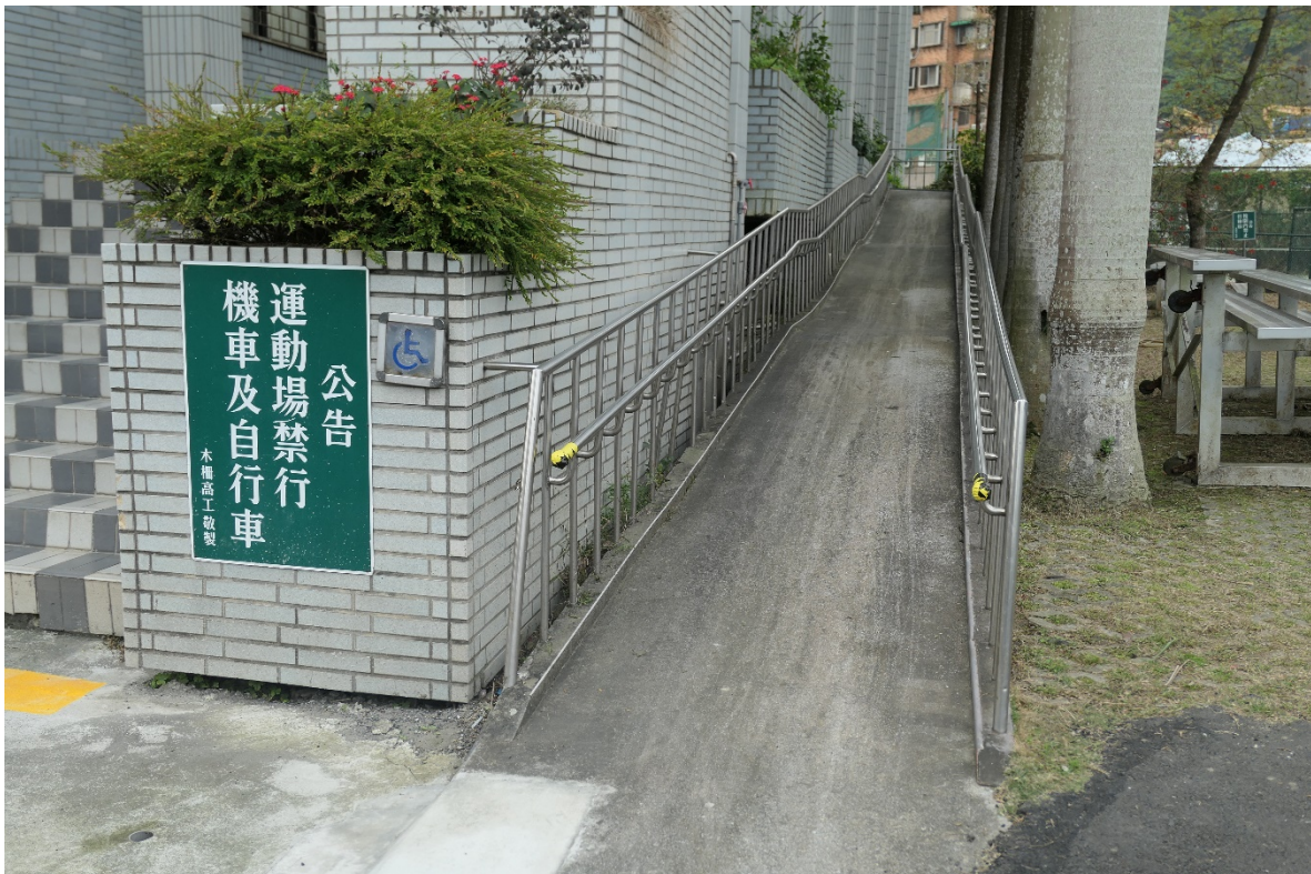
圖2 木柵高工活動中心外無障礙坡道
