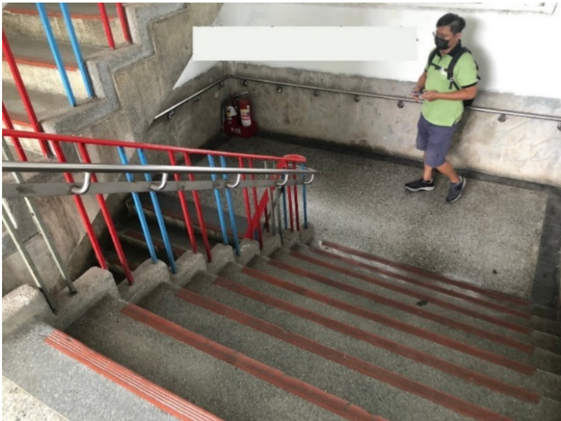
圖7 鶯歌國中各樓梯間設置扶手欄杆 (1/2)
