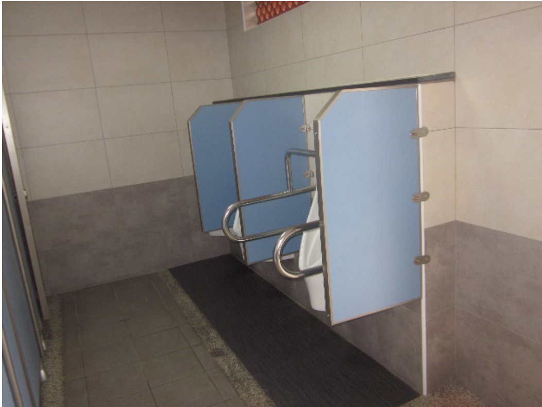
圖29 鶯歌國中特教專用廁所及無障礙廁所（含盥洗盆、照護床、求助鈴）、廁所身障扶手（8/8）
