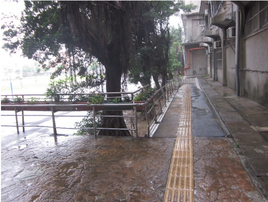
圖4 鶯歌國中操場往至明德樓、悅陽樓方向無障礙坡道
