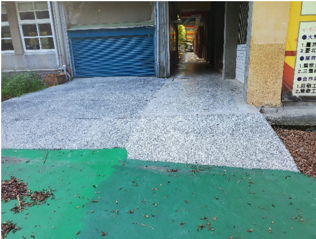
圖6 鶯歌國中窯烤庭園往新明樓、力行樓無障礙坡道
