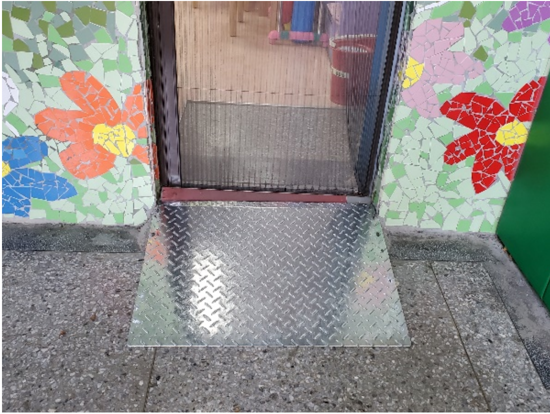
圖10 鶯歌國中活動式鋼製斜坡板 (2/2)
