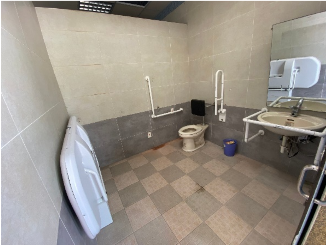
圖23 鶯歌國中特教專用廁所及無障礙廁所（含盥洗盆、照護床、求助鈴）、廁所身障扶手（2/8）
