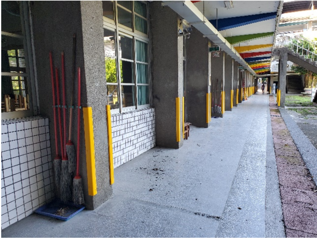
圖21 鶯歌國中1F特教、教室、幼兒園區域樑柱、牆角處設置防撞條 (3/3)
