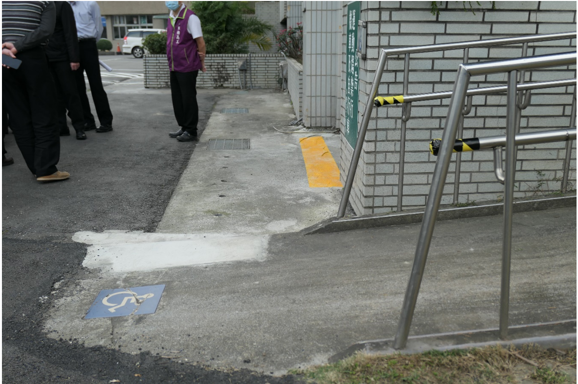
圖3 木柵高工活動中心外無障礙坡道扶手建置情形
