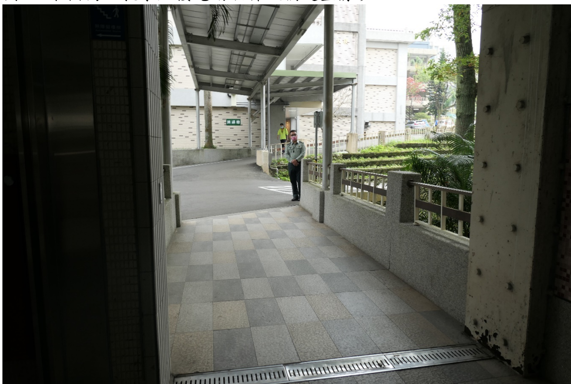
圖10 木柵高工棟連接處斜坡道
