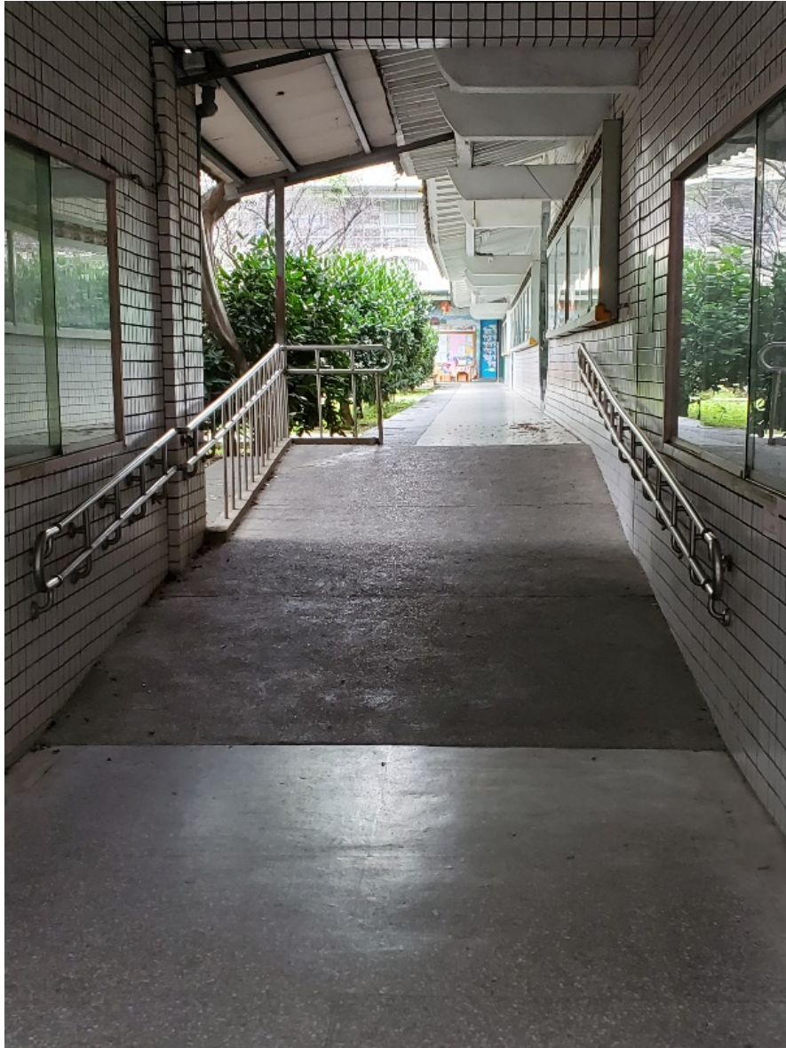
圖1 鶯歌國中文化走廊（自強樓前方）往明德樓、新明樓方向無障礙之室內通路走廊
