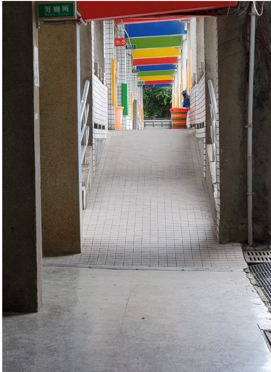
圖2 鶯歌國中悅陽樓往明德樓方向無障礙之室內通路走廊
