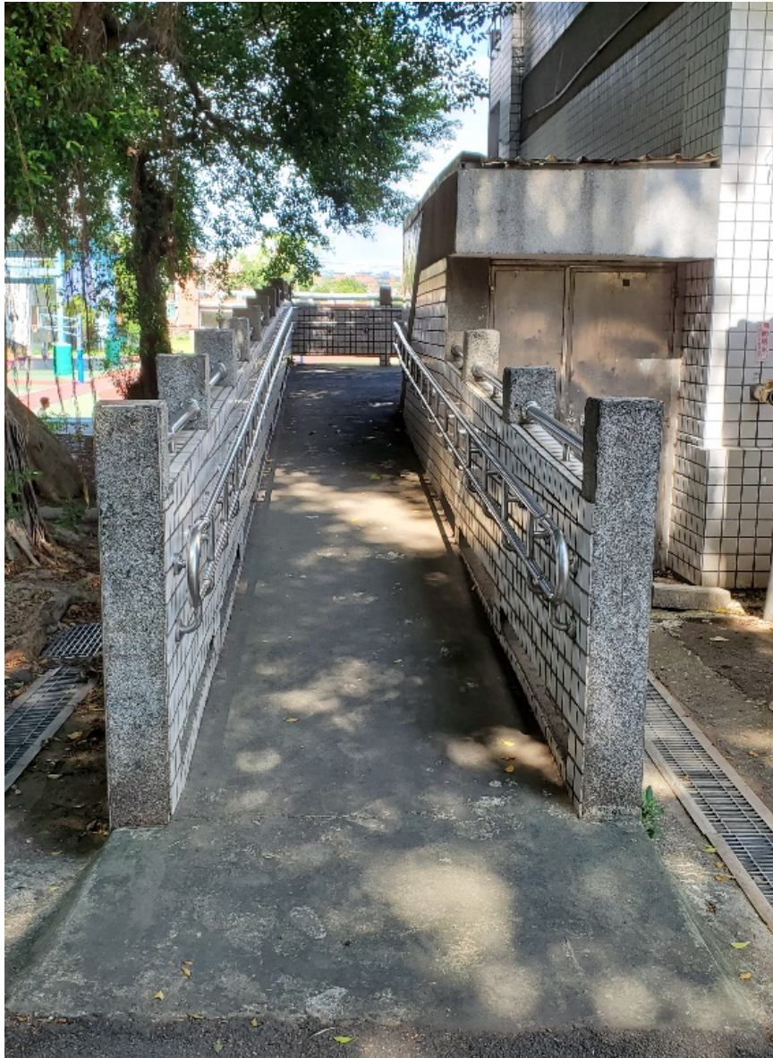
圖3 鶯歌國中停車場往悅陽樓無障礙坡道
