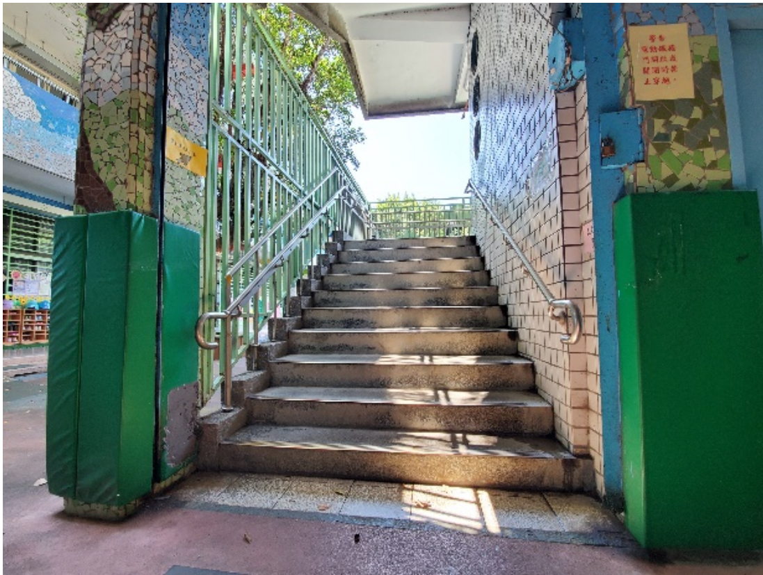
圖8 鶯歌國中各樓梯間設置扶手欄杆 (2/2)
