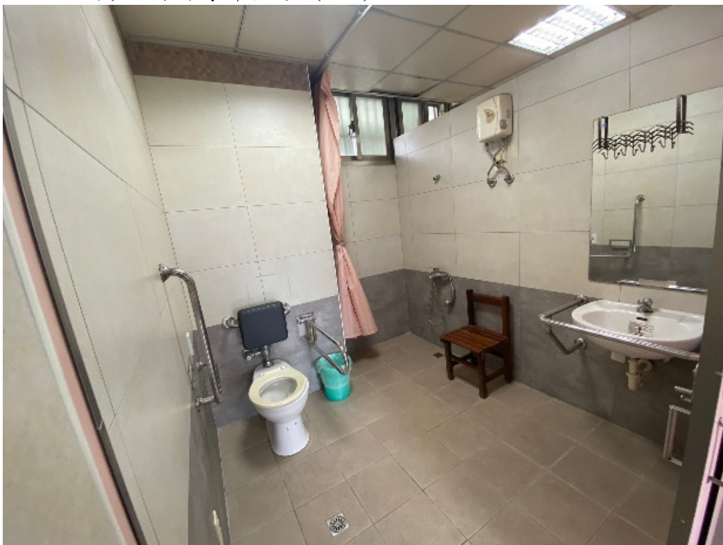
圖28 鶯歌國中特教專用廁所及無障礙廁所（含盥洗盆、照護床、求助鈴）、廁所身障扶手（7/8）
