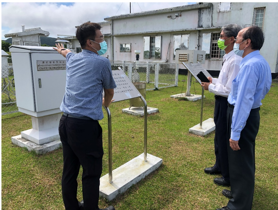
圖10 環境輻射監測站
