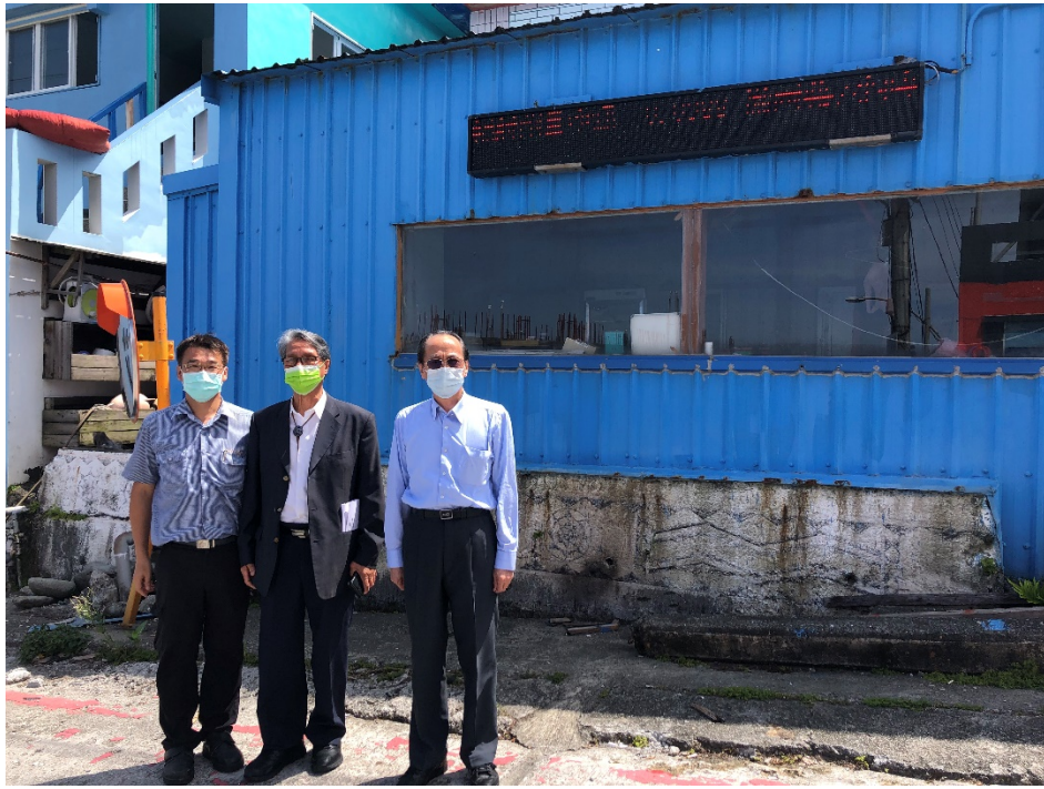
圖15 環境輻射監測站
