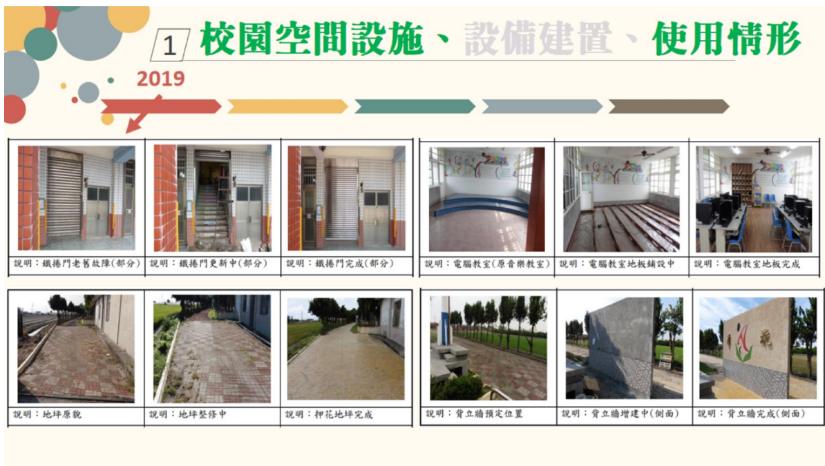
圖2 潭墘國小裝修校園空間設施之情形
