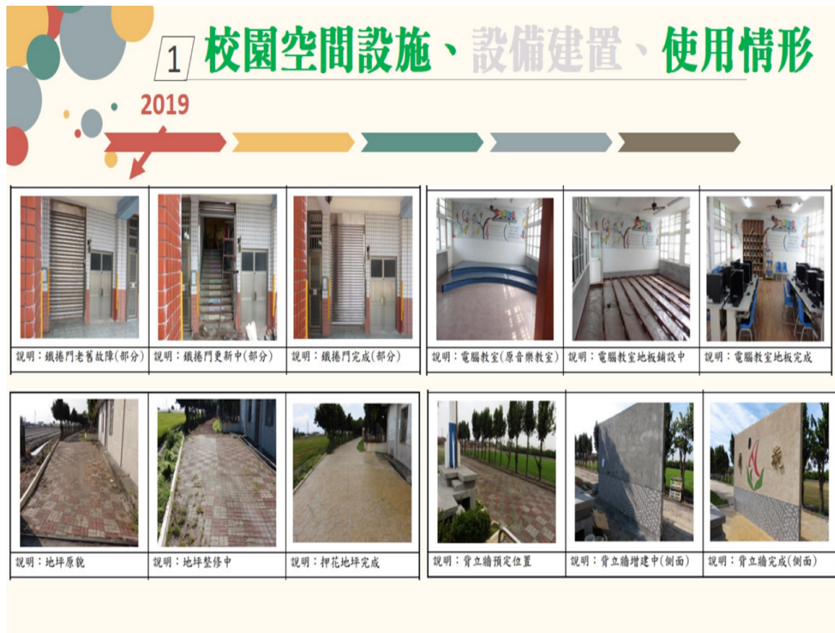
圖2 潭墘國小裝修校園空間設施之情形
