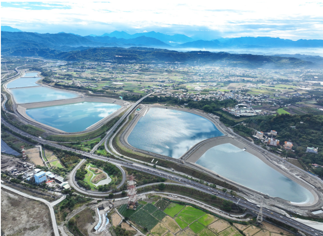
圖1 烏嘴潭人工湖6湖區蓄滿現況空拍圖
