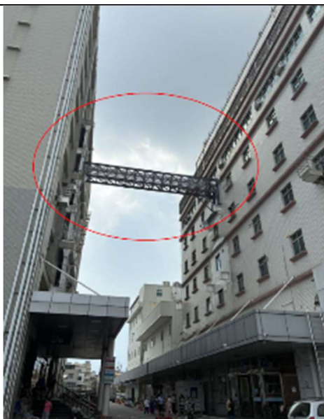
圖31 新增空中管線架
