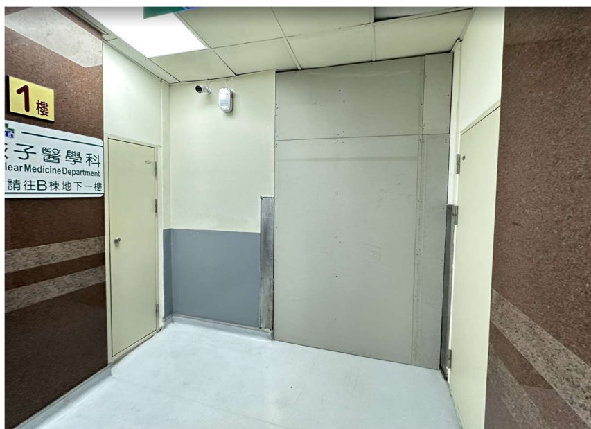
圖16 A、B棟中間5層垂直違建，僅用矽酸鈣板作為「臨時封閉」
