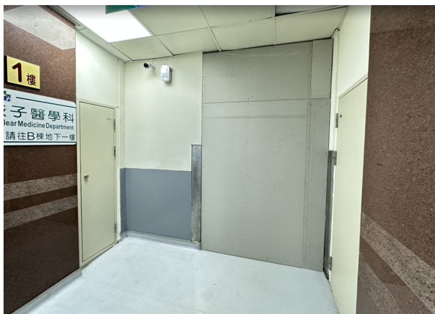
圖16 A、B棟中間5層垂直違建，僅用矽酸鈣板作為「臨時封閉」
