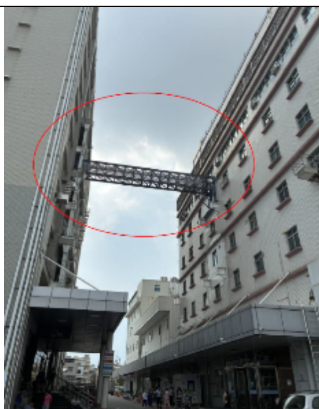
圖31 新增空中管線架
