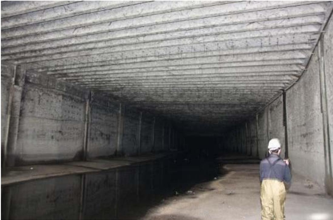
加蓋工作物拆除前土石淤積情形
