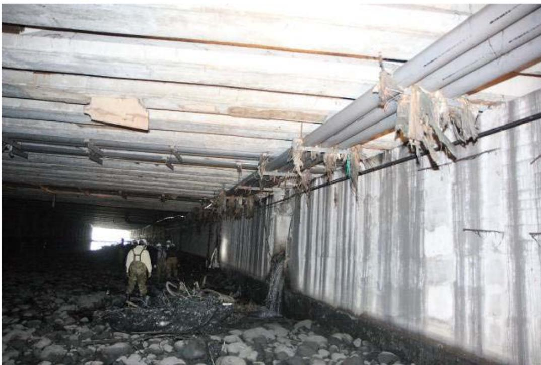
加蓋工作物拆除前中間柱阻礙通水斷面
