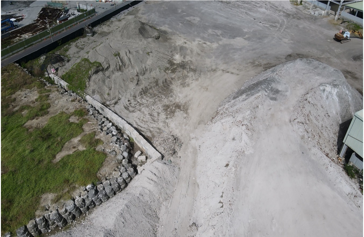
圖9 飛灰及底渣鄰近堆置及微粒造成揚塵
