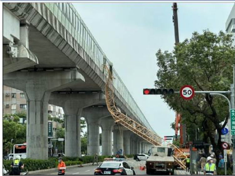
圖1 斷裂墜落之桁架侵入捷運路線
