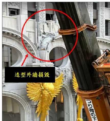
圖10 位於低層樓之造型外牆受損
