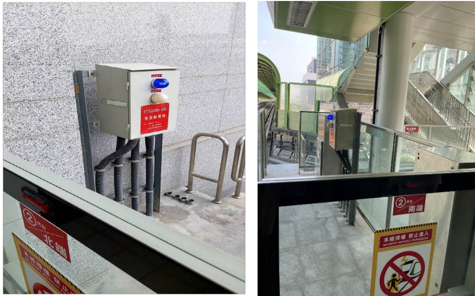
照片5 月台端牆門外方緊急斷電設備
