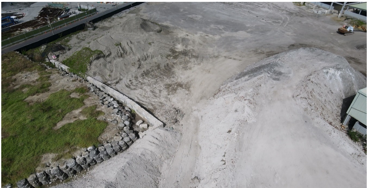
圖16 飛灰及底渣鄰近堆置及微粒造成揚塵
