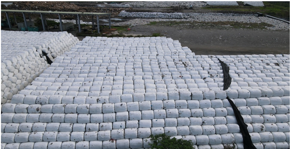
圖18 活化垃圾掩埋場挖出之舊垃圾大量暫存
