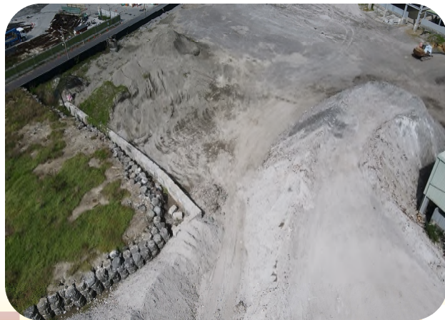
掩埋場底渣堆置區與旁邊的飛灰堆置區未做區隔且極為鄰近
