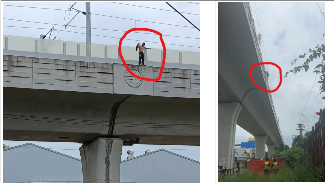
照片4 現場民眾拍攝 A 君攀附於高架隔音牆外側
