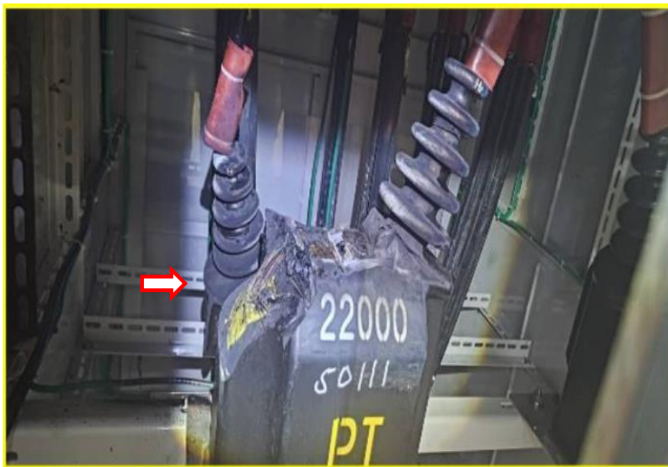
圖8 計量用模鑄式比壓器閃絡發生短路接地故障
