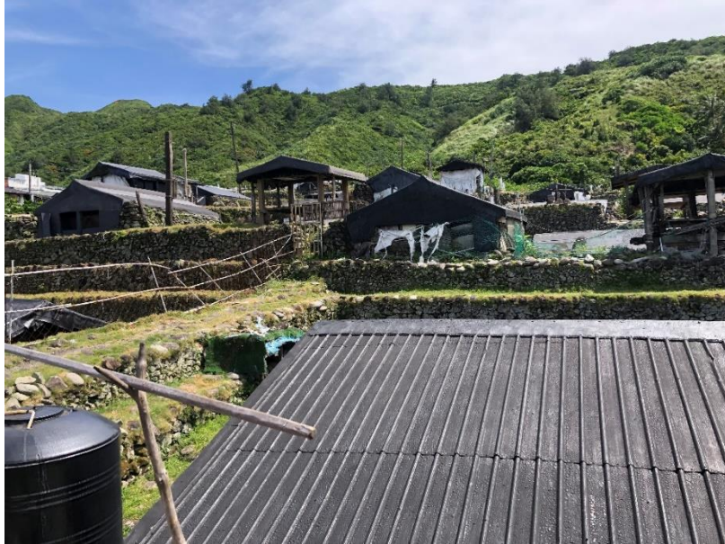
圖8 蘭嶼野銀部落地下屋現況
