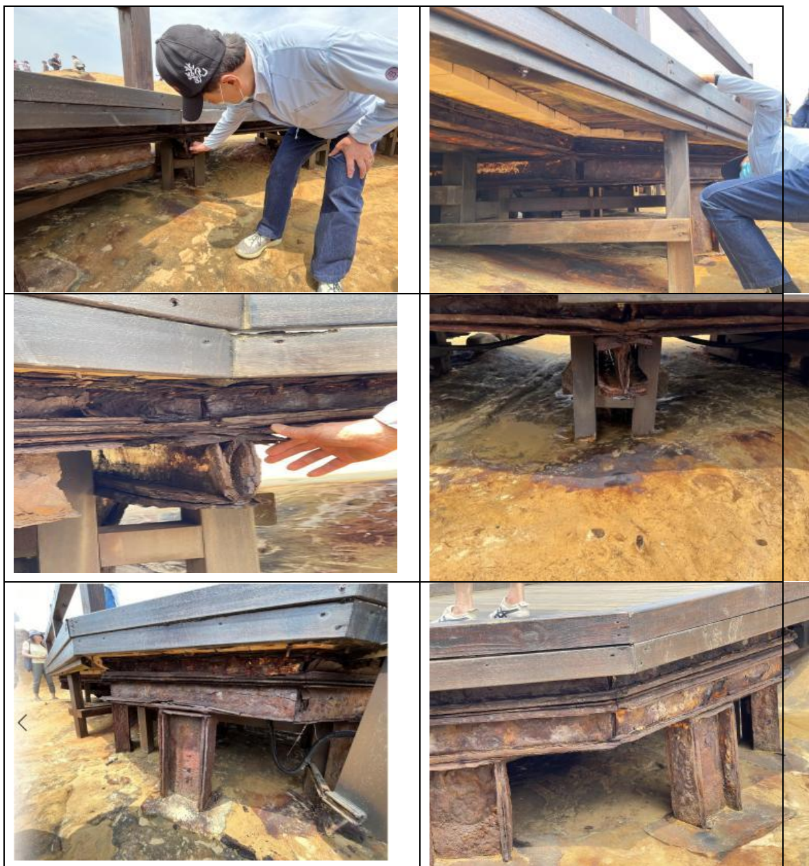
照片1 野柳地質公園女王頭旁木棧道鏽蝕、損壞情形嚴重。 資料來源：本院113.4.1履勘所攝照片（第1次履勘）。
