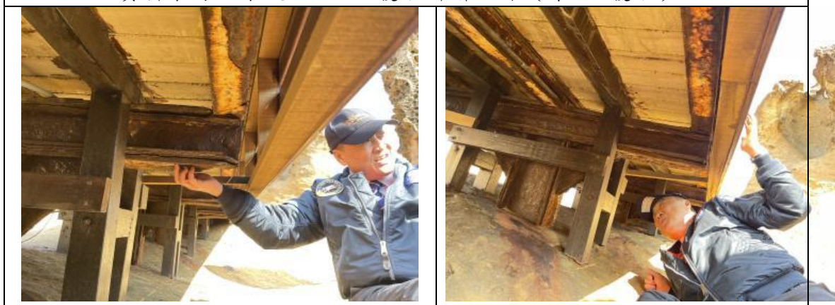
照片1 野柳地質公園女王頭旁木棧道鏽蝕、損壞情形嚴重。 資料來源：本院113.4.1履勘所攝照片（第1次履勘）。
