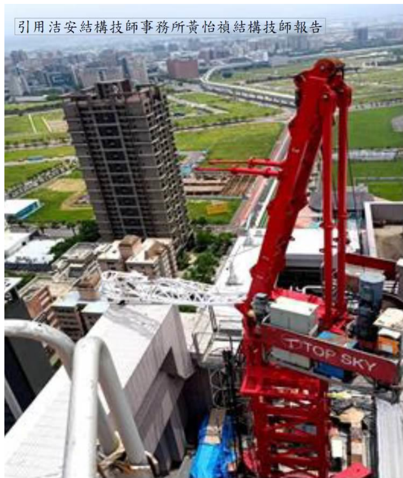
照片4 現場實際方位如所示，拆除機伸臂與外牆面至少夾 50^{\circ} 角
