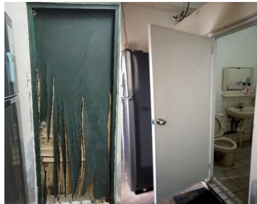
浴廁修繕前後對比
