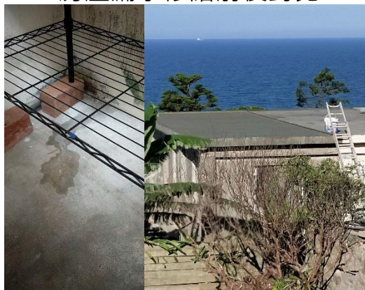
房屋漏水修繕前後對比
