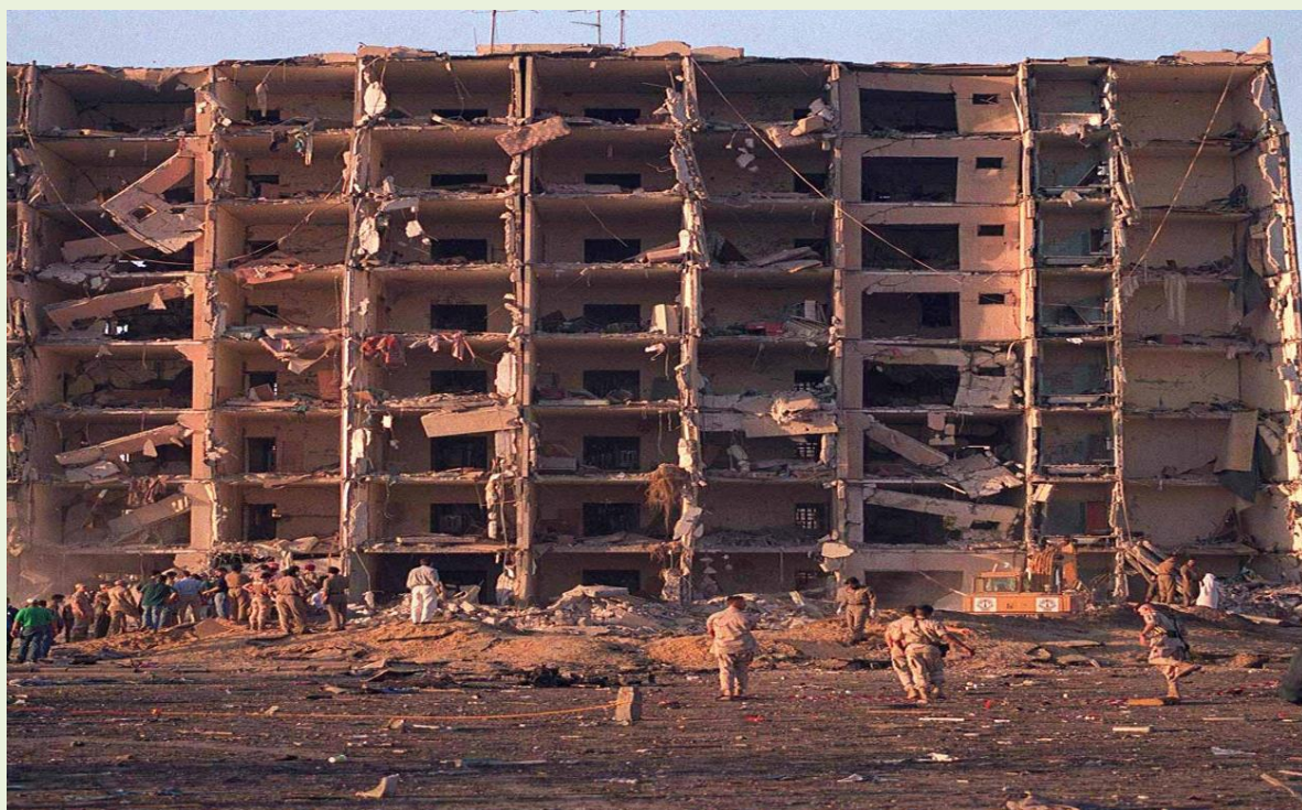
圖3 空襲後，大樓室內第2道牆後的狀況
