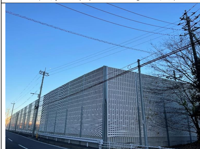
日本成田機場西側中段隔音牆1
