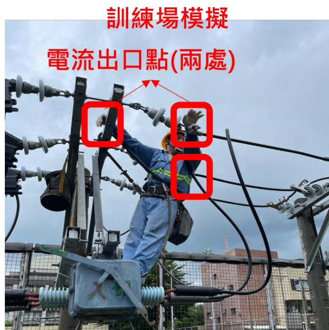
圖1 台電公司外包廠商112年8月2日於南投縣魚池鄉維修電桿之感電死亡現場及模擬圖
