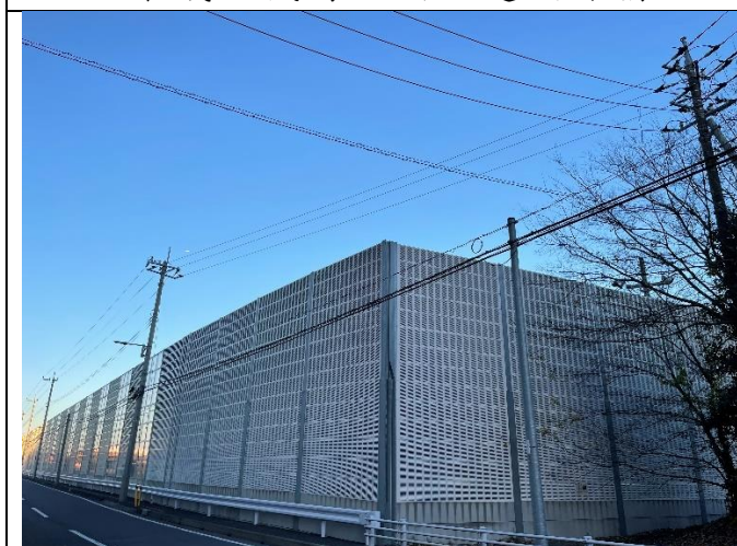
日本成田機場西側中段隔音牆1
