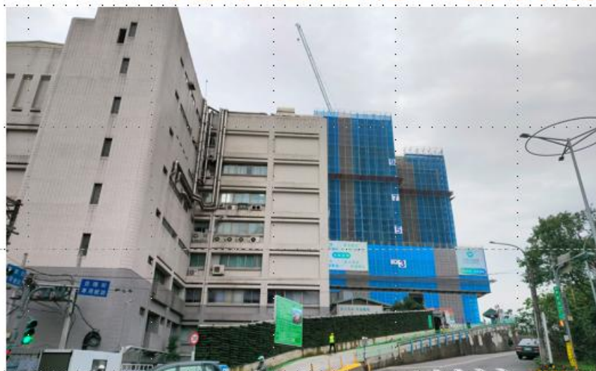
工地出入口照片
