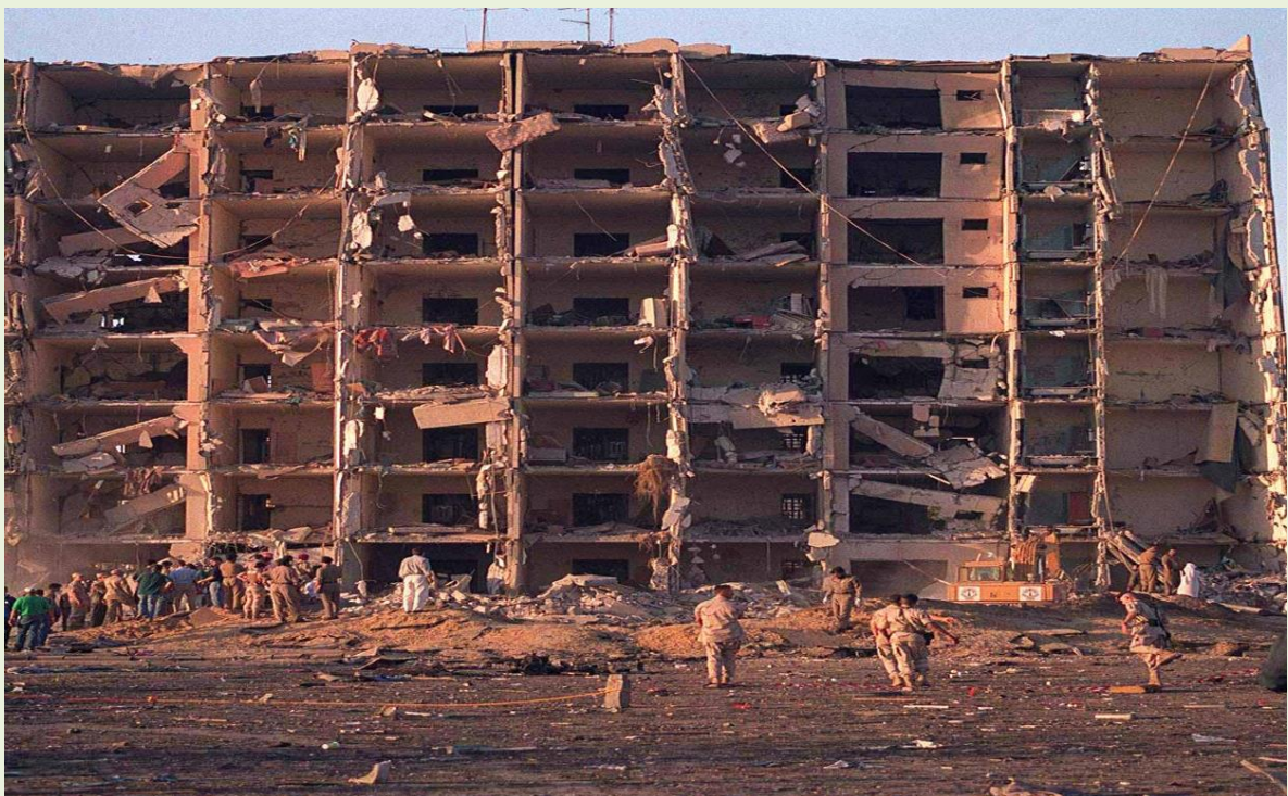
圖3 空襲後，大樓室內第2道牆後的狀況
