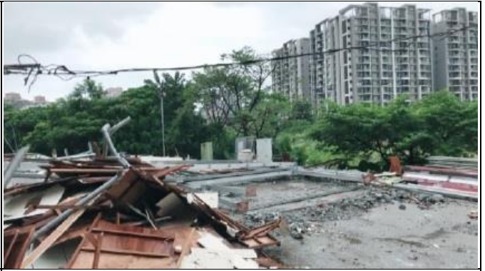
圖6 新北市政府續拆除未完成部分
