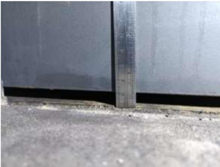
圖5 本事件殉職消防員所在房間管道間及天花板間隙佐證照片
