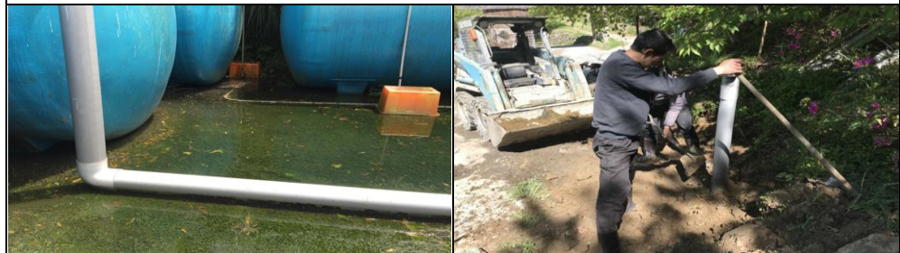
A區處理槽：進水井、藍色的污水處理槽，不斷的溢出來污水，污水就積在水泥地上。為期改善惡臭問題，族人增設排氣孔，希望連到各家戶、民宿的臭味可以減緩，惟執行成效有限。
