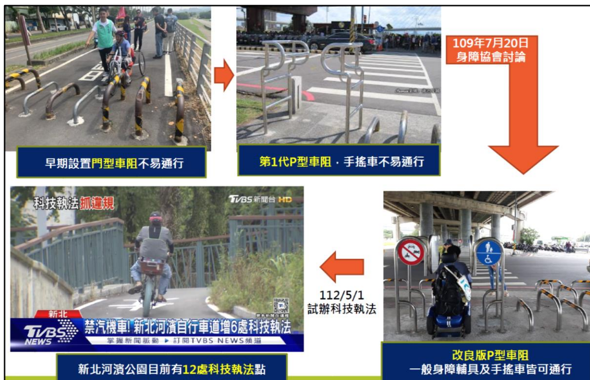
圖2 高灘處改善車阻情形 資料來源：高灘處113年9月20日履勘簡報
