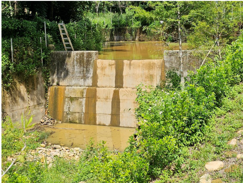
照片2 第2座攔砂壩
