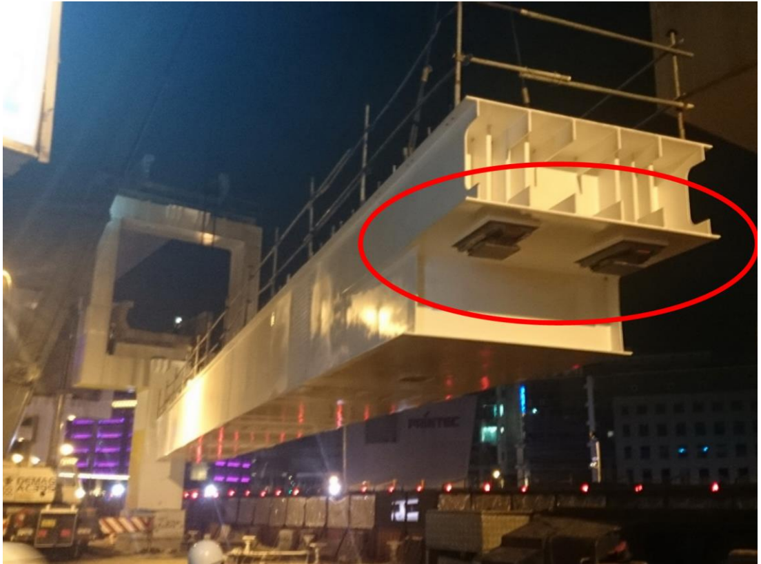
圖7 橋梁吊裝時調坡板已與支承結合，屬隱蔽部分
