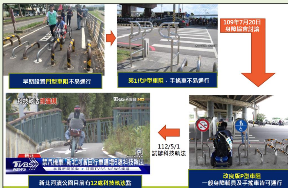
圖4 高灘處改善車阻情形
