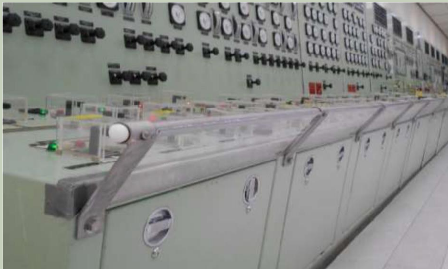
圖9 控制室操作盤面增設安全防護桿及壓克力擋版
