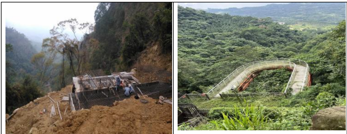
圖4 龍鳳瀑布空中步道當時施工與現況照片 資料來源：南投縣政府履勘簡報第26頁、本院113.8.26所攝照片。
