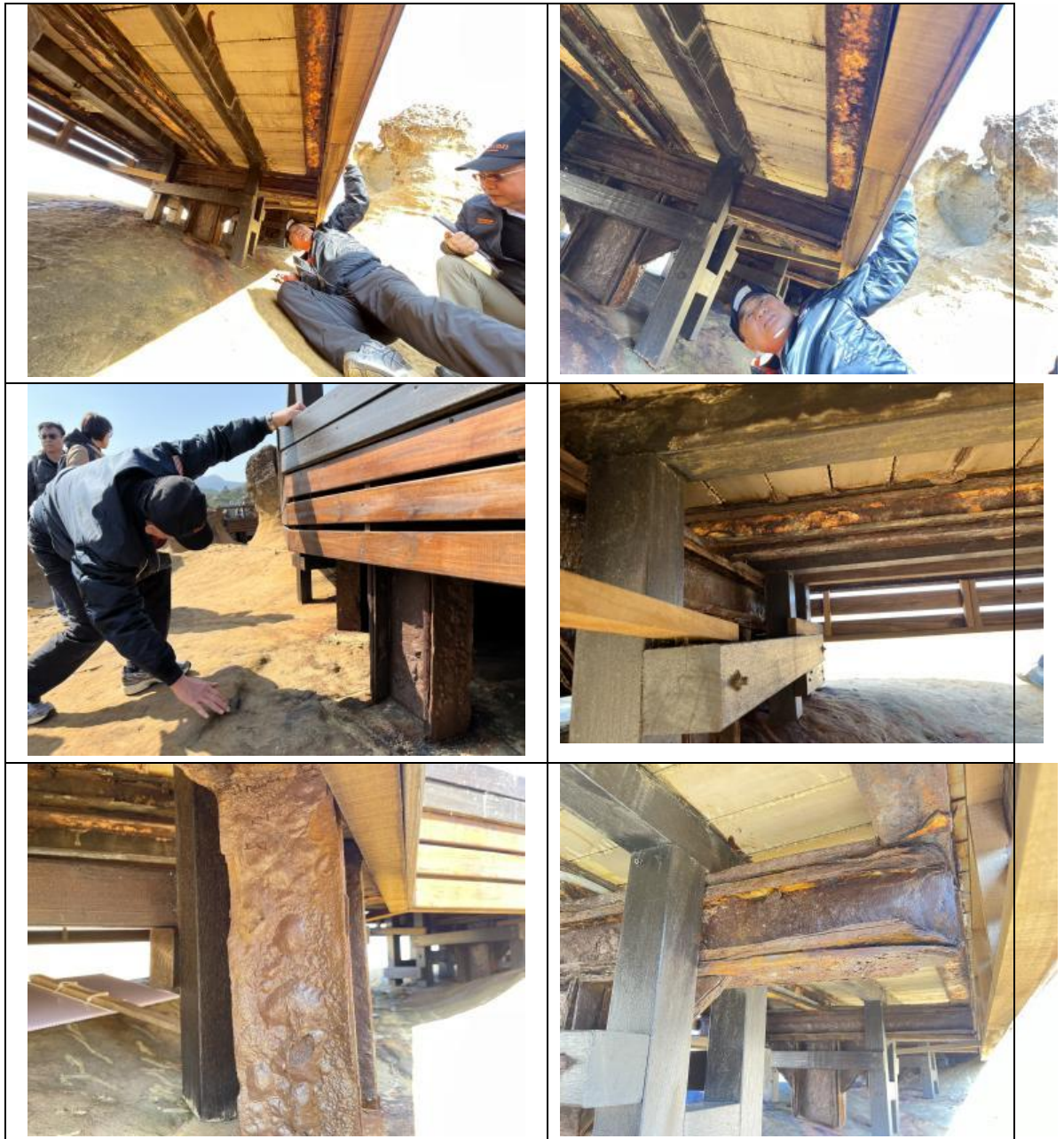
照片2 野柳地質公園女王頭旁木棧道改善後情形，仍然可見鏽蝕情形。 資料來源：本院114.1.20履勘所攝照片（第2次履勘）。
