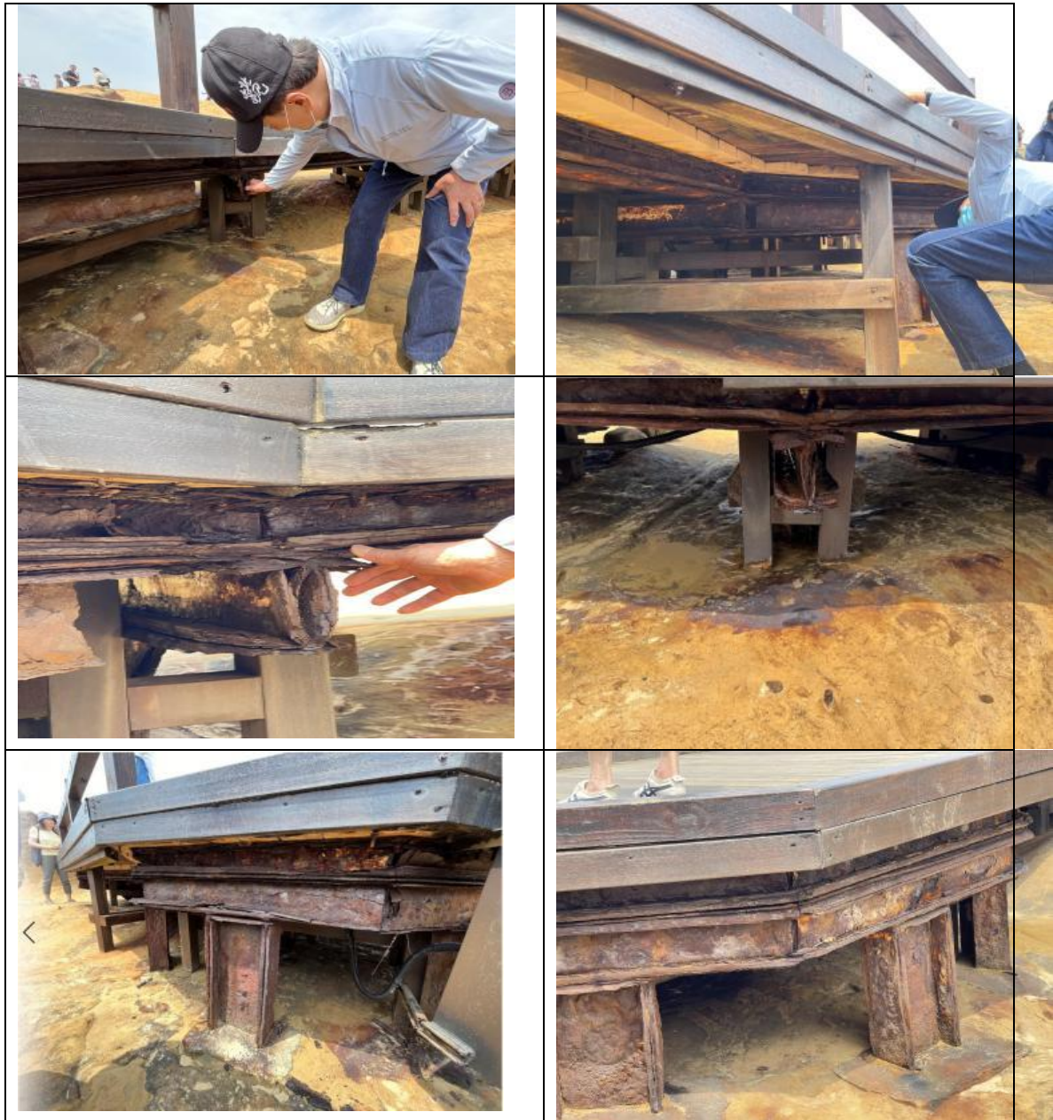
照片1 野柳地質公園女王頭旁木棧道鏽蝕、損壞情形嚴重。
