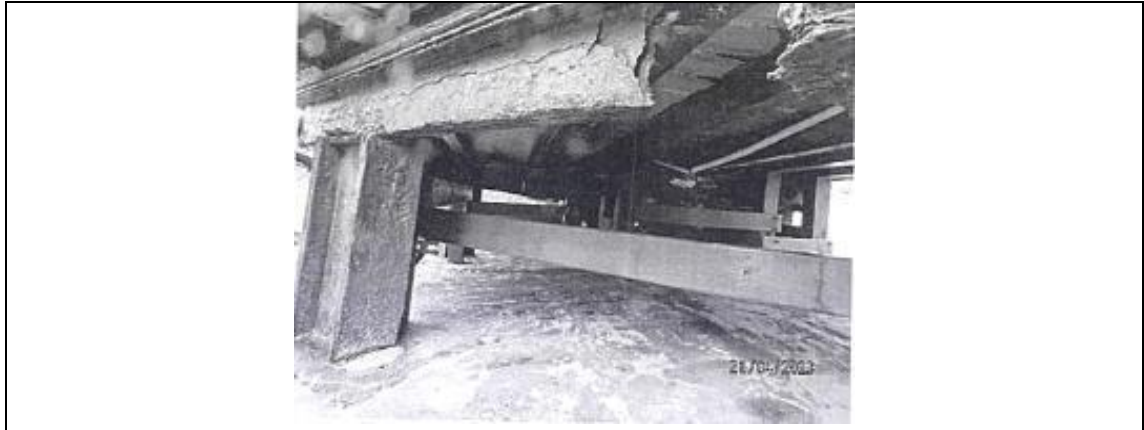
圖2 野柳地質公園景觀橋及木棧道（R木棧道）橋梁下部現況照片 資料來源：111-112年北觀管理處轄管橋梁及構造物巡檢工作委託技術服務案，第4次定期檢測成果報告書。
