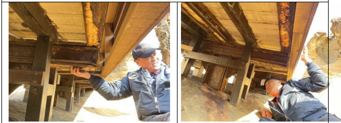
照片1 野柳地質公園女王頭旁木棧道鏽蝕、損壞情形嚴重。
