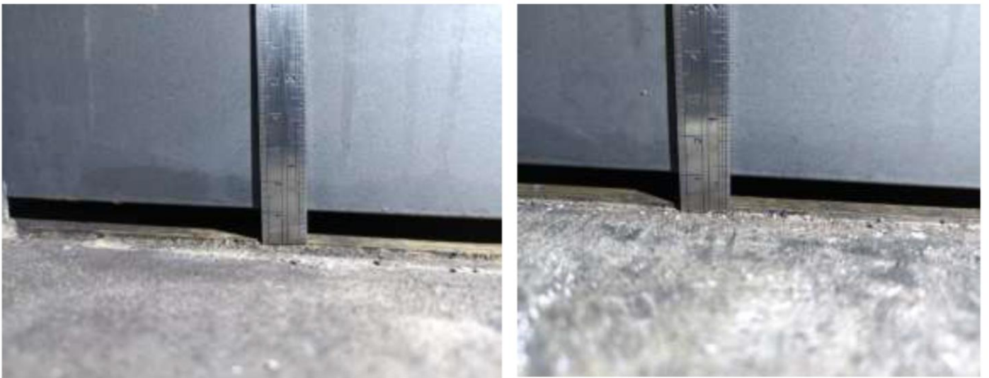
圖5 本事件殉職消防員所在房間管道間及天花板間隙佐證照片
