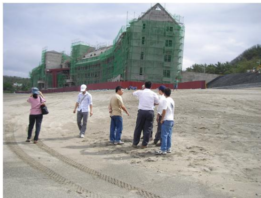
圖4 美麗灣拓建既有鋪面，新增之駁坎已連接至建物第2層
