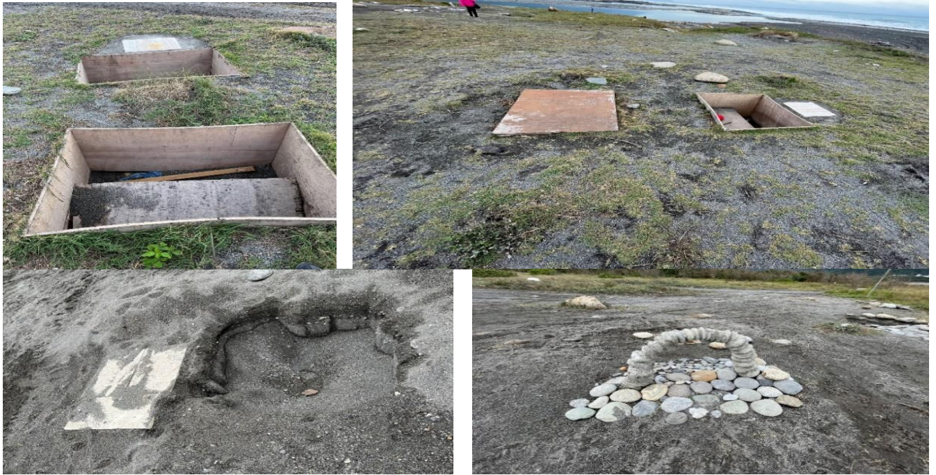
照片3 順安三棧海灘之人工設施物，隨處可見業者獨占性使用設置物品及用來固定設施之水泥，嚴重破壞地貌與地景。
